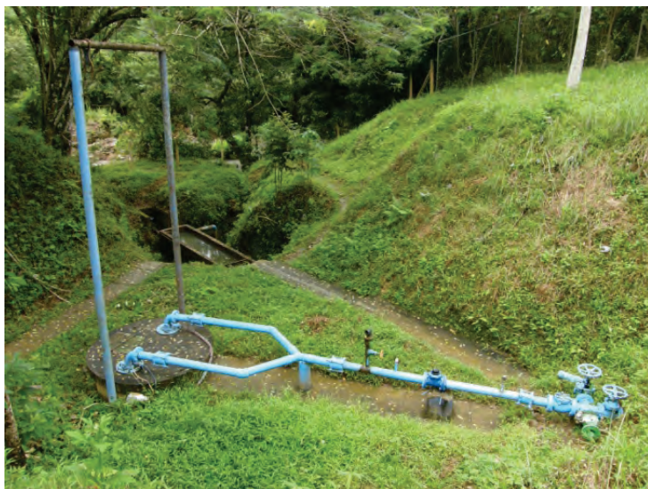
Een te kleine bezinkbak, slechte pompen en een te krappe hoofdleiding
